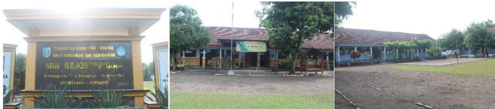
Gambar 1. Kondisi SDN Rejosopinggir
